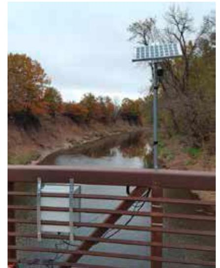
Station de surveillance des eaux superficielles alimentée à l'énergie solaire
