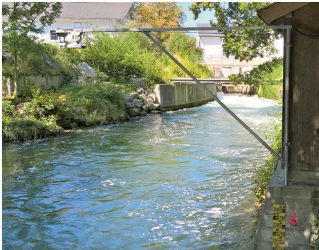
Bild 2: Ott-SVR-100-Durchflussmesssystem am Pegel Aiblingen
