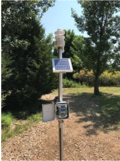
Foto: Der neue Datenlogger im Einsatz
