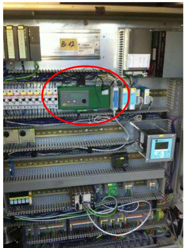
Schaltschrank am Brunnen 17 mit OTT netDL1000 und Buskonverter für Profinet Anbindung an die SPS
