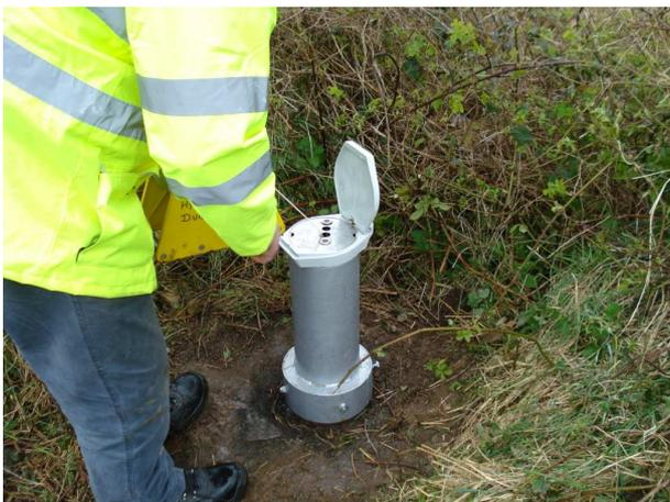
Messstelle im Bog of the Ring: Hier sind 2 OTT Orpheus Mini in verschiedenen Tiefen installiert. Mit dem OTT KL 010 Kabellichtlot werden Referenzmessungen gemacht. (Bild: M.Browne, Ireland EPA)
