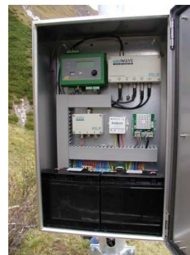
Technik an der Messstation
