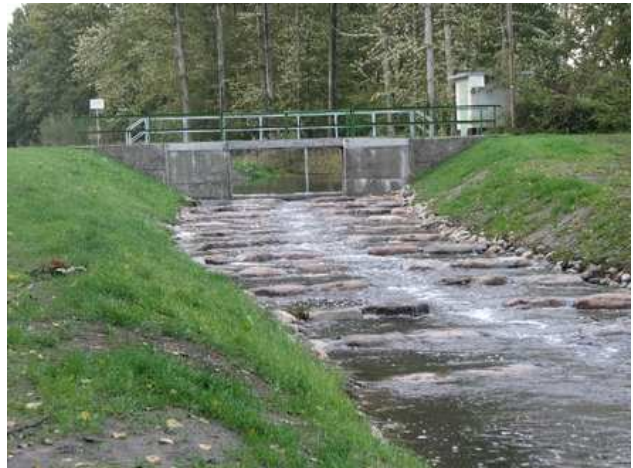
Sohlgleite am Rothentor nach Fertigstellung (Foto: StAUN Schwerin)
