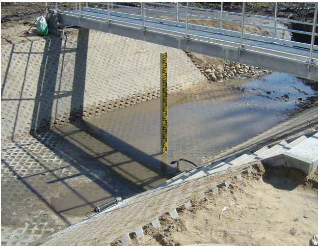
Trapezförmiger Ausbau und Befestigung im Bereich des Messquerschnitts (Foto: StAUN Schwerin)
