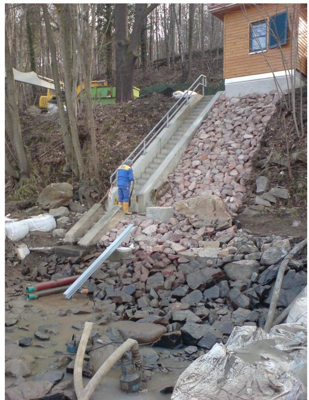
Die Pegelanlage während der Rekonstruktion. Deutlich sind im trockengelegten Gewässerbett die Halterungen für die beiden SLD-Sensoren zu erkennen.
