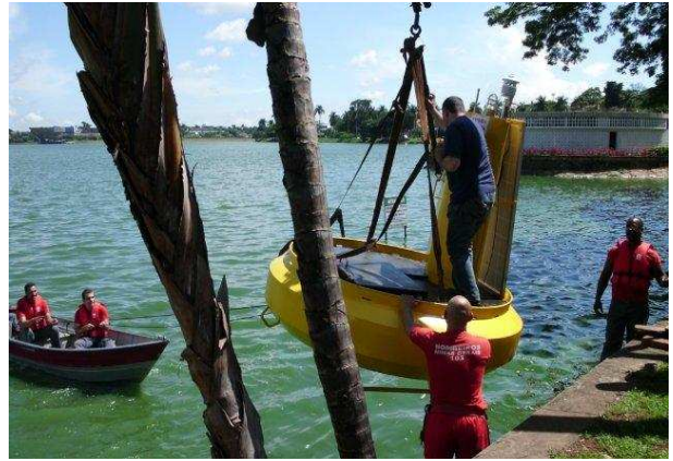
Eindrücke von der Installation der Boje mit logistischer Unterstützung durch die Feuerwehr
