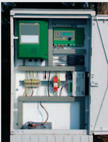
Sistema de medición ultrasónico con controlador de estación LogoSens para la medición continua del caudal "Q". Instalado en una carcasa Rittal, alimentado por energía solar y con telemetría GSM siendo una estación totalmente independiente.
