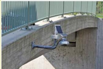
Komplette Station unauffällig installiert an Brücke/Ausleger
