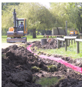
Réalisation de tranchées
